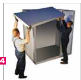
4. Сборка потолочных панелей
